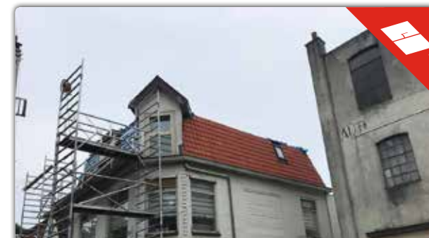
DAKPANNEN VERVANGEN/RENOVEREN MET TUILE DU NORD
