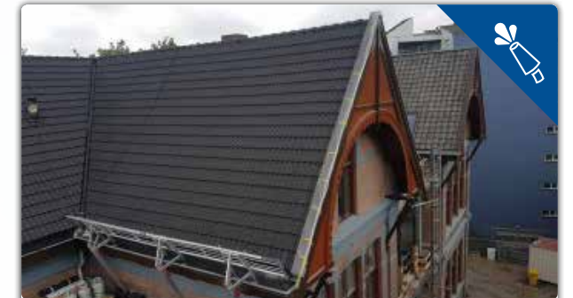
DAKPANNEN COATEN VAN MONUMENTAAL PAND IN GRONINGEN
