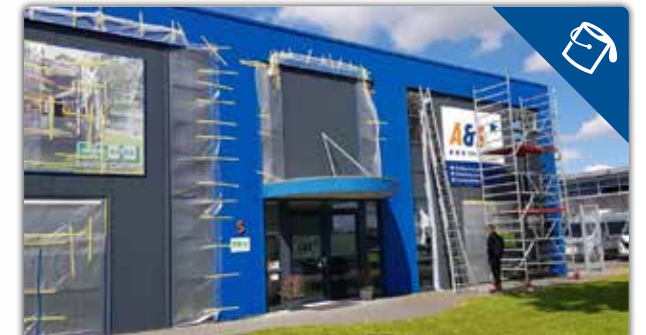
HET PAND VAN A&S IN KOLHAM OPNIEUW GECOAT
