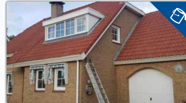
IN MUNTENDAM EEN WONING VOORZIEN VAN RODE DAKCOATING
