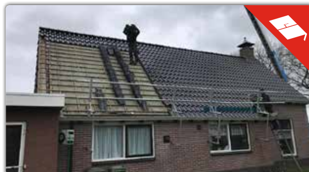
OUDE DAKPANNEN VERVANGEN DOOR NELSKAMP H15
