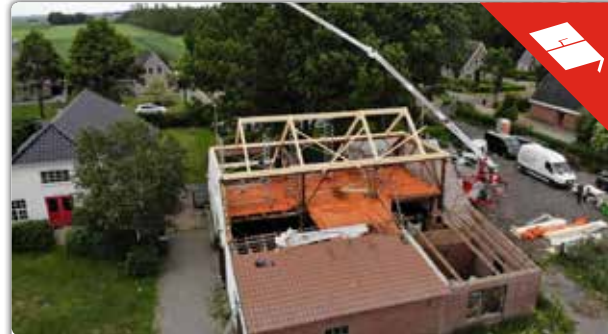
NIEUWE DAK LEGGEN OP SCHUUR
