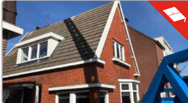
DAK VOORZIEN VAN MORGOVENT FOLIE EN DAKPANNEN
