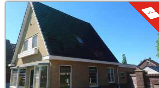
DAKPANNEN VERVANGEN VOOR INDAK- ZONNEPANELEN
