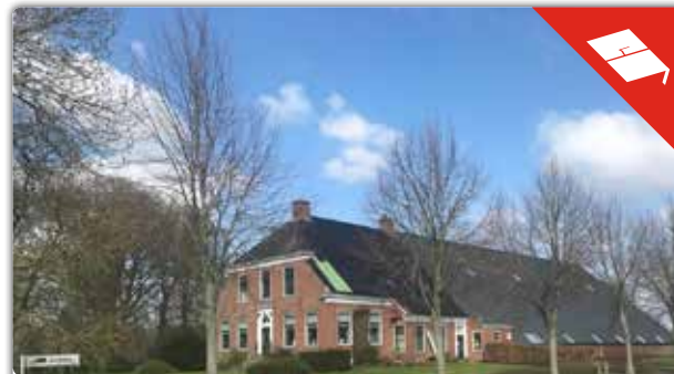
WONING VOORZIEN VAN UNIDEK ISOLATIE EN DAKPANNEN
