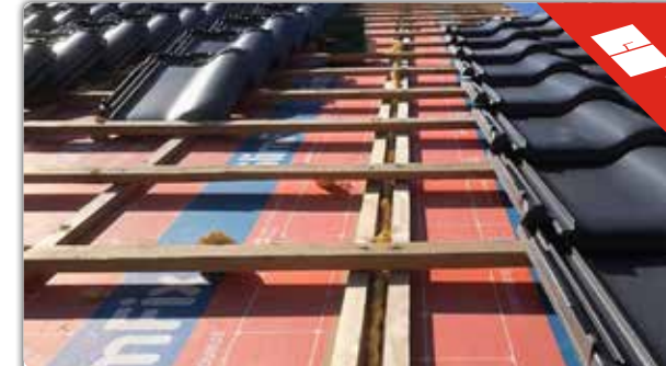
DAKPANNEN OP EEN WONING LEGGEN
