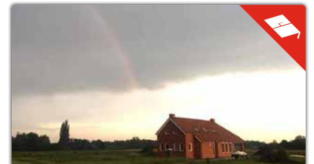
RODE DAKPANNEN VAN KORAMIC LEGGEN
