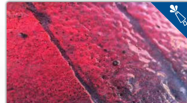
VERF VERWIJDEREN MET REMMERS AFBIJTPASTA
