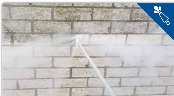
MUREN REINIGEN MET HEET WATER
