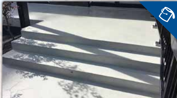
STOEP VAN WOONZORGCENTRUM VOORZIEN VAN NIEUWE COATING
