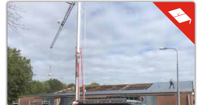
ASBEST GOLFPLATEN VERVANGEN DOOR GEÏSOLEERDE STAALPLATEN
